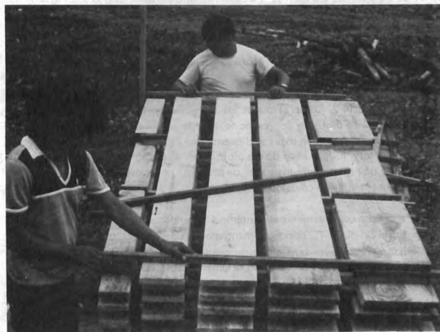
Figuras 1 y 2. Cimientos para las pilas.
